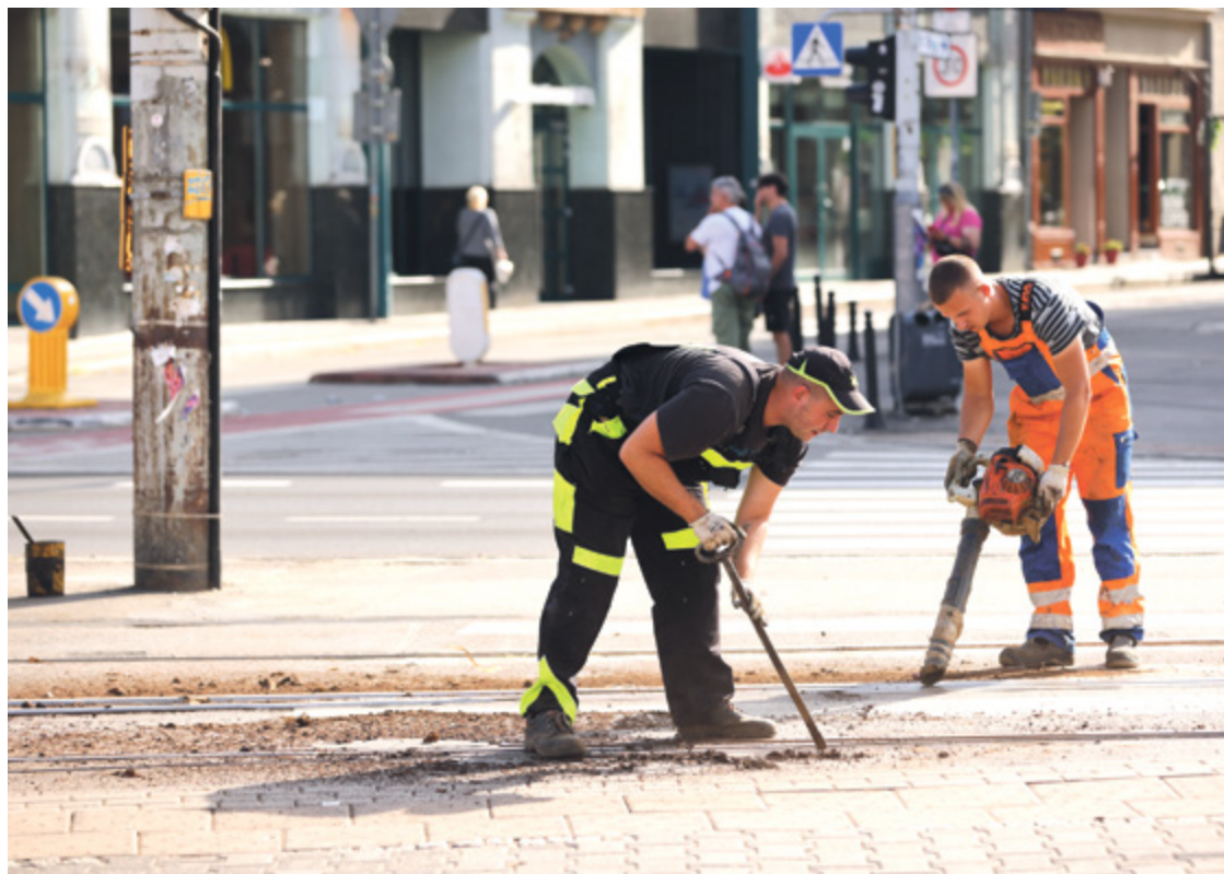
Prace na torach i w sieci trakcyjnej będą prowadzone w sześciu lokalizacjach, a także w trzech zajezdniach
